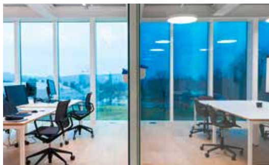
Bei Bewölkung durchsichtig, bei Sonnenschein abgedunkelt: Elektrochrome Fenster passen sich dem Wetter an.
