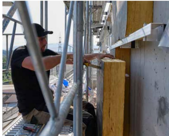
Les rouleaux flexibles en fibres de verre peuvent être coupés à la taille souhaitée sur le chantier. Ils sont particulièrement adaptés à l'isolation des constructions en bois.
