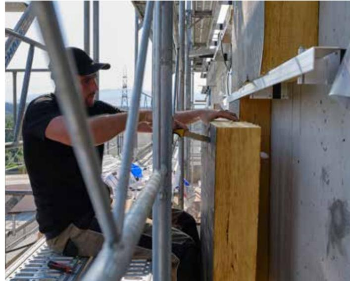
*Flexible Glasfaserrollen lassen sich auf der Baustelle auf die gewünschte Grösse zuschneiden. Sie eignen sich insbesondere als Dämmung für den Holzbau.*
