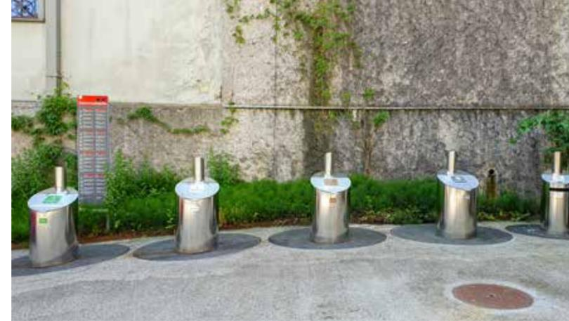
Grâce à des capteurs de niveau dans les conteneurs, les responsables savent à tout moment si un conteneur doit être vidé.
