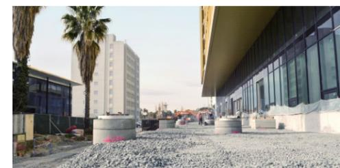
*Utilisation dans la construction routière: remblai léger sur un terrain de faible portance.*
