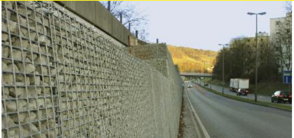
La ghiaia in vetroschiuma prodotta con vetro usato viene utilizzata anche per le pareti fonoassorbenti lungo le arterie stradali.
