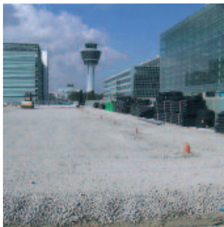
Nuovo aeroporto di Monaco (D): sottofondo di Misapor per le piazze di stazionamento dei velivoli
