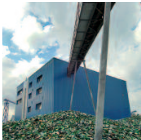
Stabilimento di produzione; Misapor, Dagmarsellen LU
