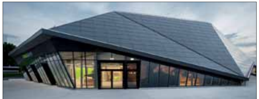
Das futuristische Gebäude der Umweltarena. Die Dachfläche ist vollständig mit Photovoltaikmodulen ausgestattet.
