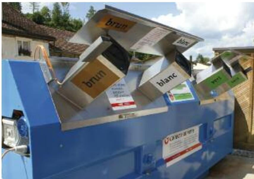
Container «Croque-Bouteille» mit den Einfüllstutzen für farbetrenntes Einwerfen. Im Inneren werden die Flaschen auf die optimale Scherbangrösse zerkleinert.
