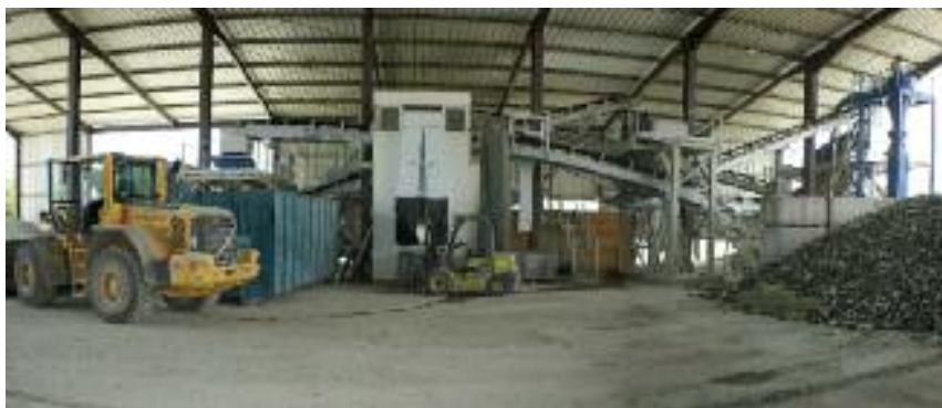
Panoramafoto der Farbtrennungsanlage bei Euroverre in Biolley-Orjulaz in der Nähe von Lausanne.
