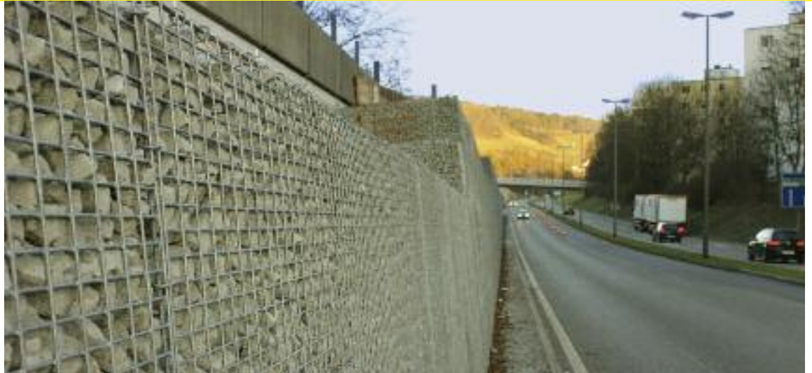
Der aus Altglas hergestellte Schaumglasschotter wird immer öfter auch für schallschluckende Schutzwände im Strassenbau eingesetzt.
