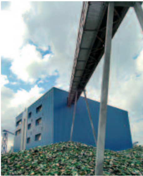
Produktionsgebäude in Dagmersellen LU
