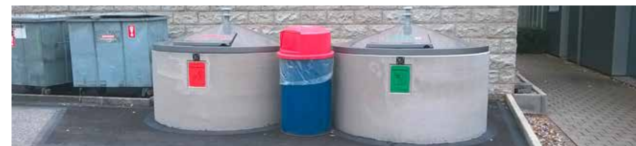
Nouveau point de collecte avec conteneurs semi-enterrés pour le verre usagé, l'aluminium et le fer blanc à Landquart.
