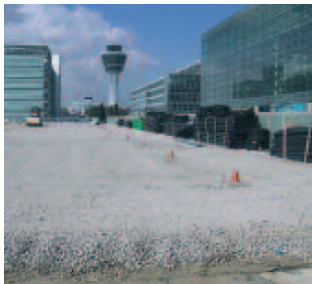
Nouvel aéroport de Munich, remblayage des aires de stationnement des avions avec Misapor
