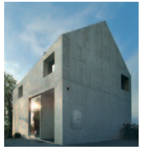
Maison individuelle futuriste en Misapor-Béton à Coire
